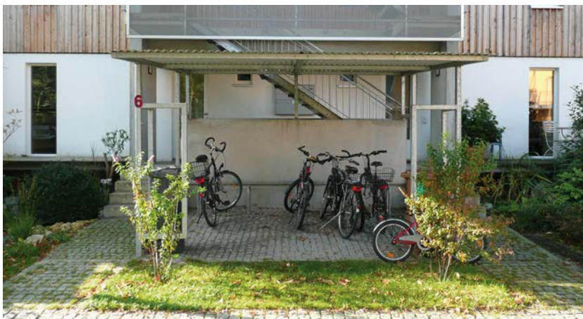
Bei Gesamtsanierung der Siedlung integrierte Veloparkierung
