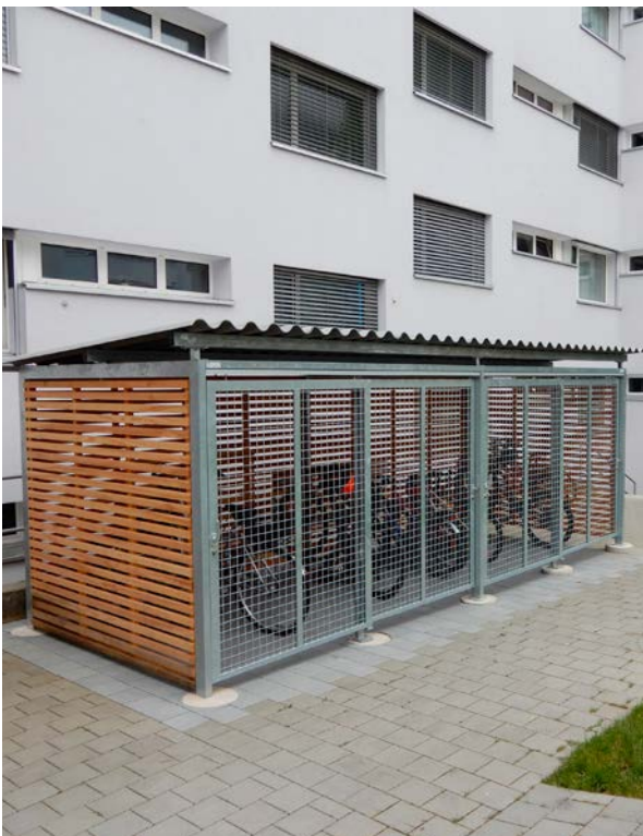
Abschliessbare Anlage mit eingeschränktem Benutzerkreis
