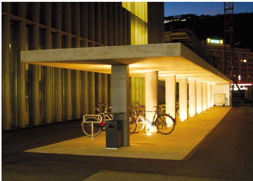
Gut beleuchtete Anlage in massiver Bauweise
