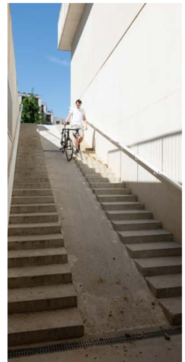
Mittig angeordnete Schieberampe mit den Abmessungen 0.8 m, 0.9 m, 0.8 m
