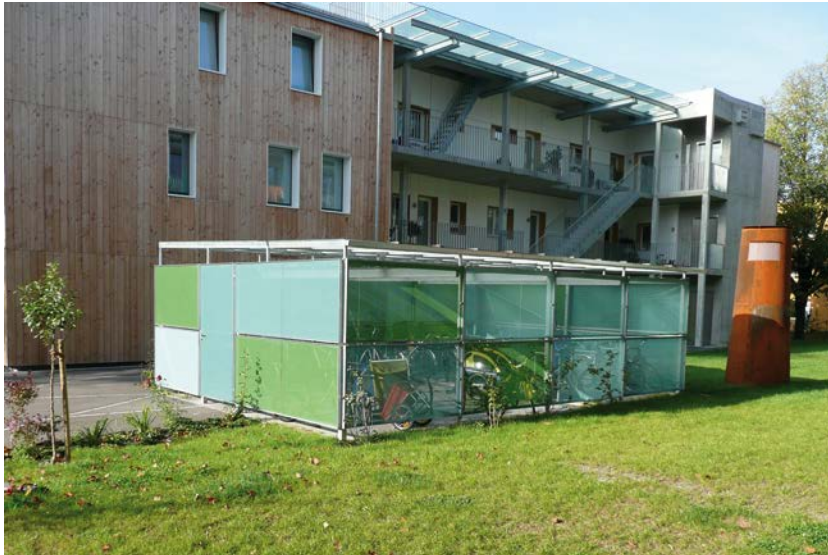
Veloparkierung in Nebengebäude
