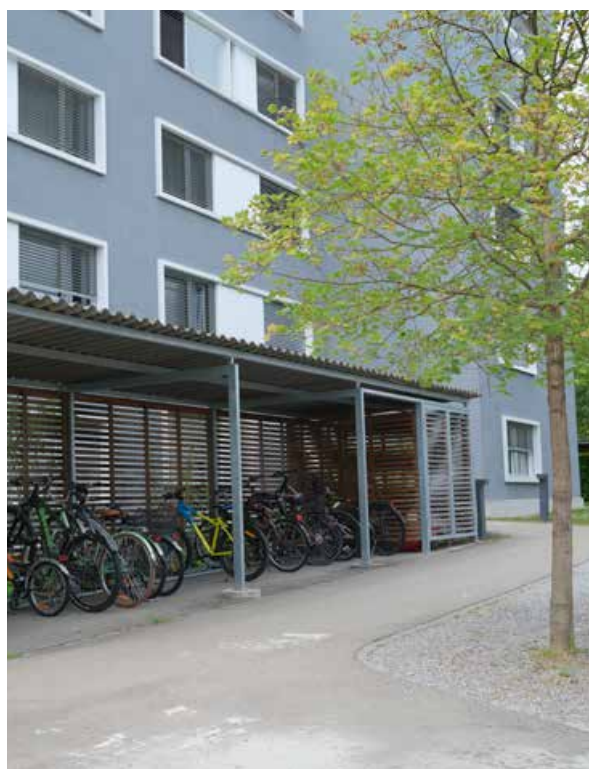
Installation ouverte couverte, visible depuis l'espace public
