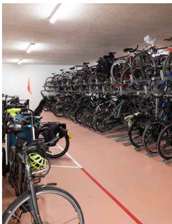
Installation verrouillable combinée avec un parking souterrain
