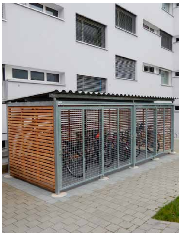
Installation verrouillable à accès restreint
