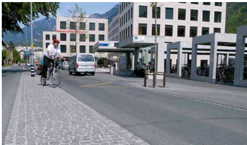
Une aide au tourner-à-gauche au centre de la chaussée et des bordures de trottoir abaissées facilitent l'accès
