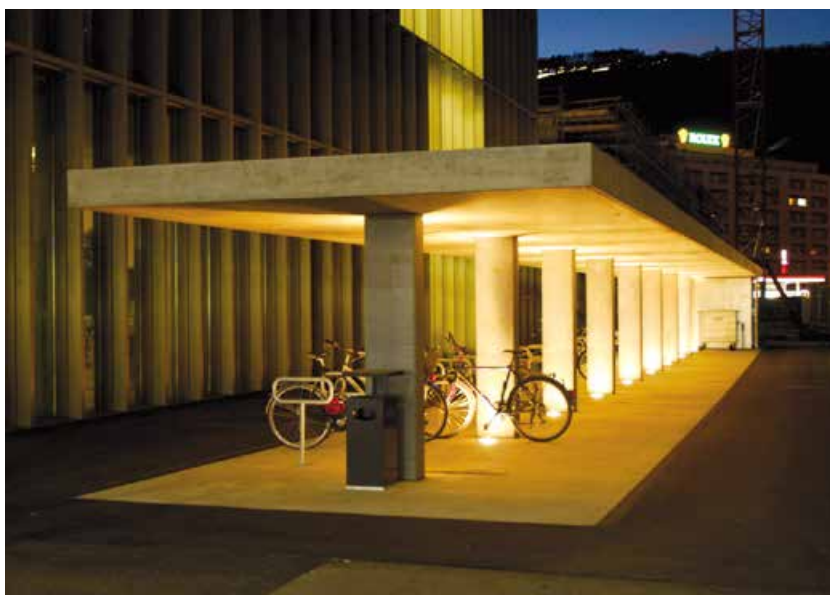
Installation bien éclairée, réalisée en construction massive
