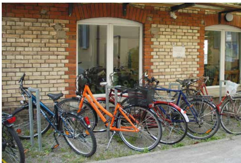
Stationnement vélo couvert pour une petite entreprise
