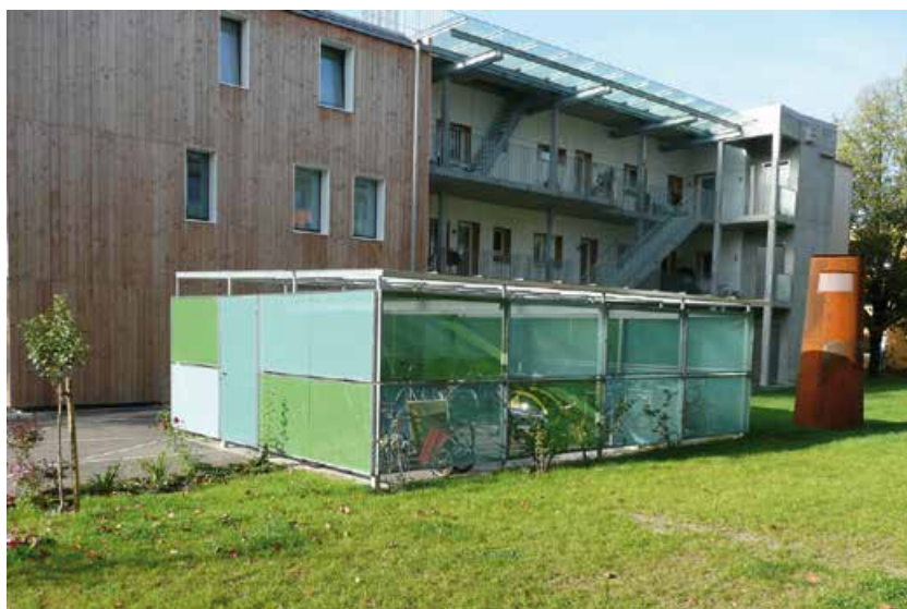
Abri à vélos indépendant avec parois latérales et paroi arrière
