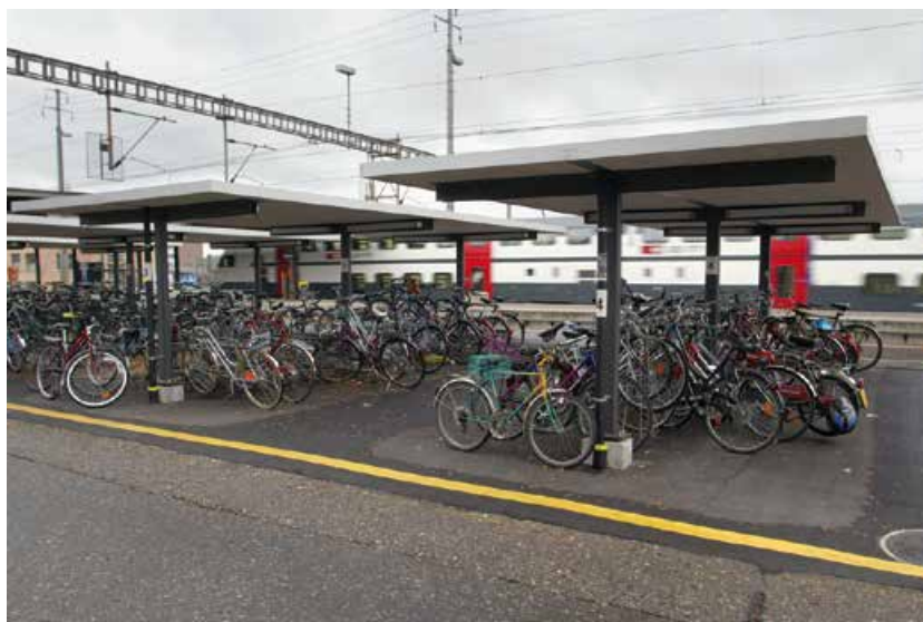
Places vélo à proximité du quai, couvertes et éclairées
